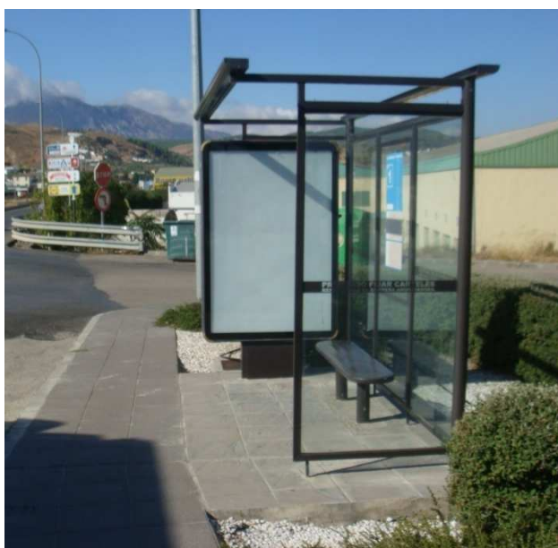
Parada de autobús dotada de un refugio con mobiliario de estancia
