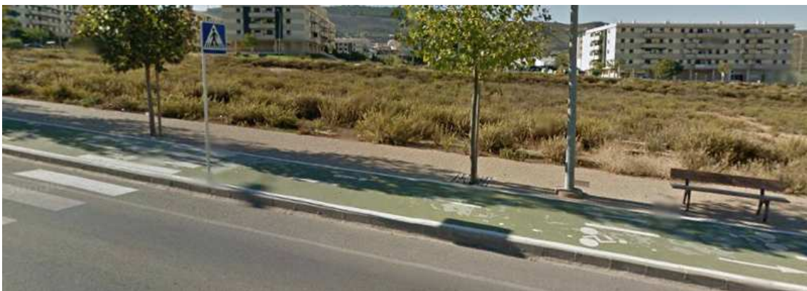
Carril bici en conflicto con el itinerario peatonal
