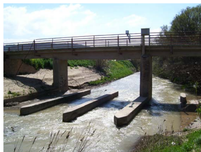
AMPLIACION DE LA ESTRUCTURA, QUE DA CONTINUIDAD DESDE LA CALLE SAN LUIS A UN CAMINO RURAL, ADAPTANDOSE AL ENCAUZAMIENTO PROPUESTO.
