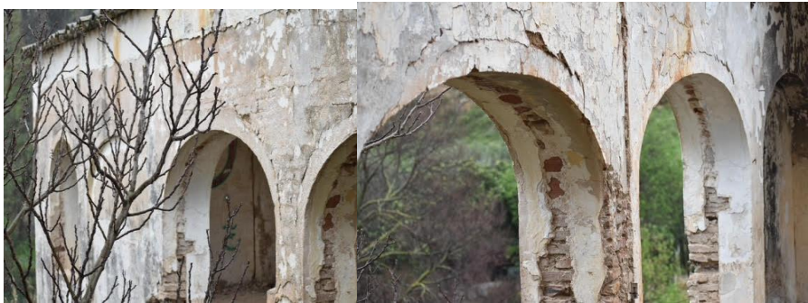
Fotografía propia realizada el 07/03/2025 desde el exterior a la izquierda apreciando los arcos de descarga con ladrillo macizo. Y desde el interior a los mismos arcos en la derecha se observa el detalle del tipo de ladrillo.
