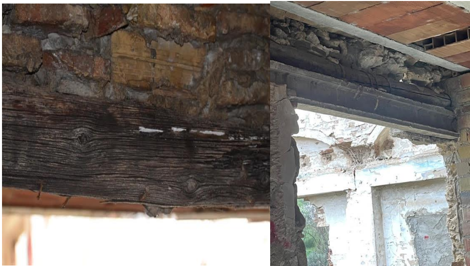
Fotografía propia realizada el 07/03/2025, A la derecha, en algún caso se conserva la vigueta de madera y en otros la de madera ha sido reforzada por la de hormigón.
