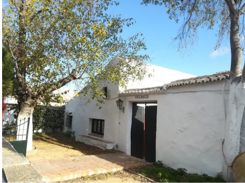
Vivienda rural Fachada principal
