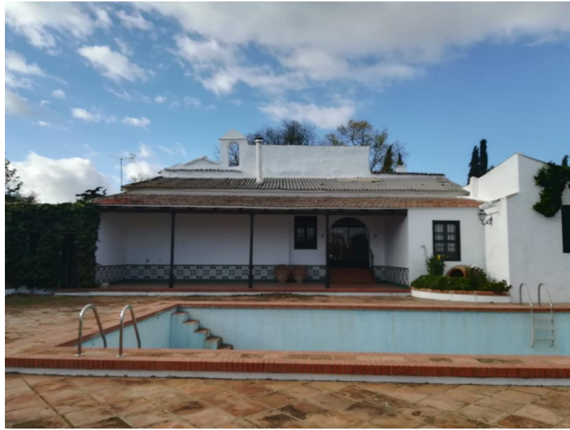
Vivienda rural Fachada patio trasero
