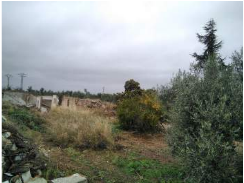
Vistas del sector desde el sur, desde el Cmno. del Partido Gandía. Mirando en sentido NO, con el Centro de tecnificación de atletismo al fondo (arriba), y mirando hacia el N, con la edificación demolida en parcela 157 (abajo). Nótense las líneas de MT que cruzan el sector
