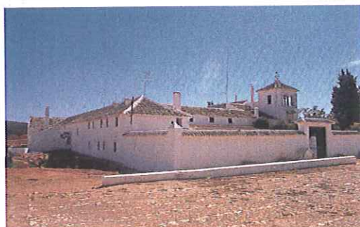
Vista del conjunto con la tapia y portón de acceso desde un patio lateral.
