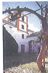
Patio principal con detalle de la torre.
