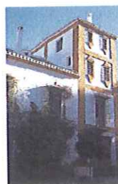
Fachada exterior de la torre mirador.
