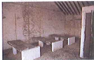
Dormitorio de trabajadores.
