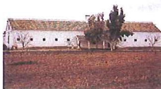
Fachada trasera y fachada principal.
