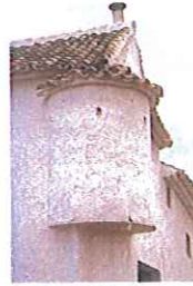
Garita en esquina de planta circular.
