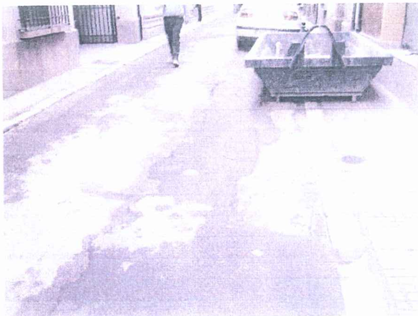
Imagen 1. Pavimentación Calle Laguna
