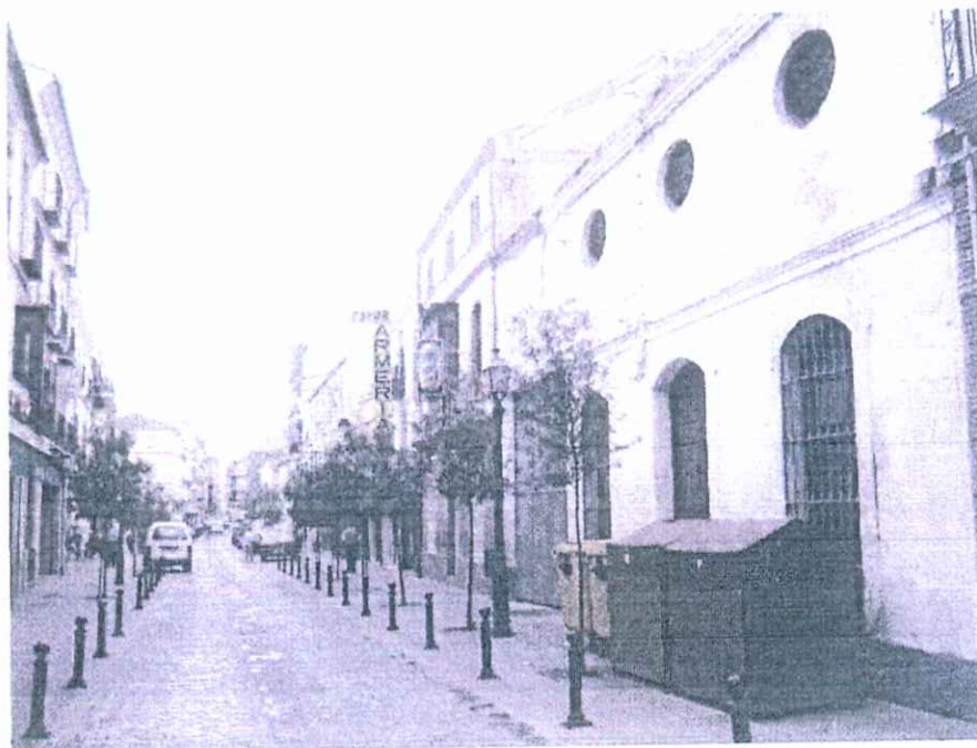
Imagen 20. Calle Calzada (I)
