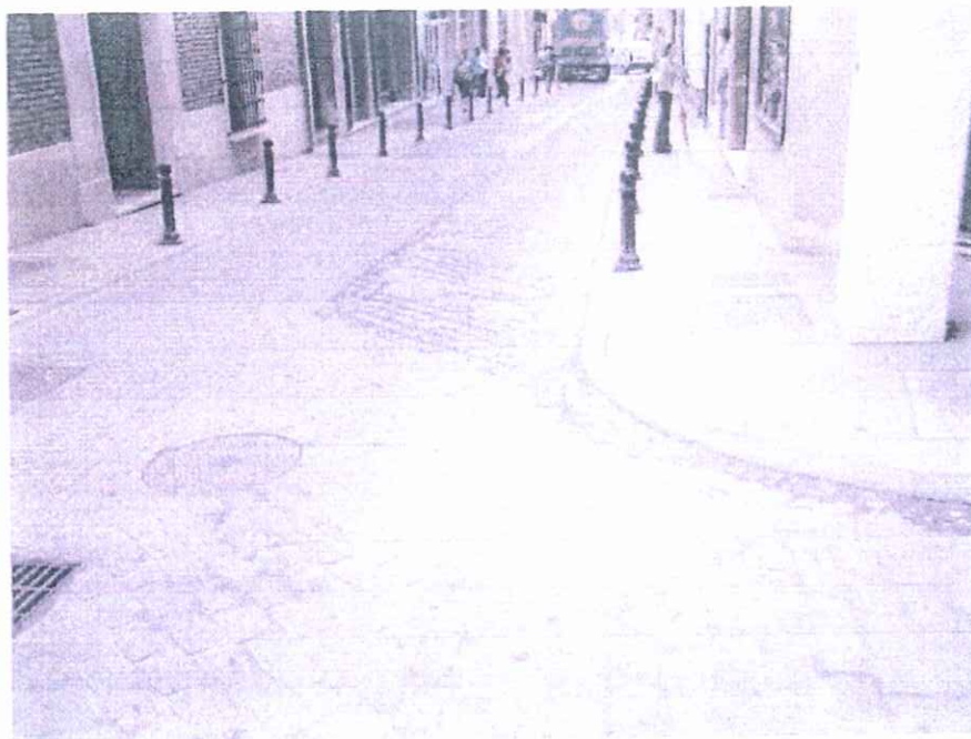
Imagen 3. Bordillos rebajados y bolardos
