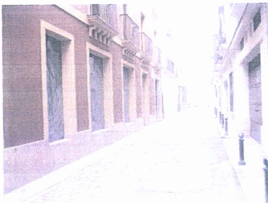
Imagen 2. Pavimentación Calle La Gloria
