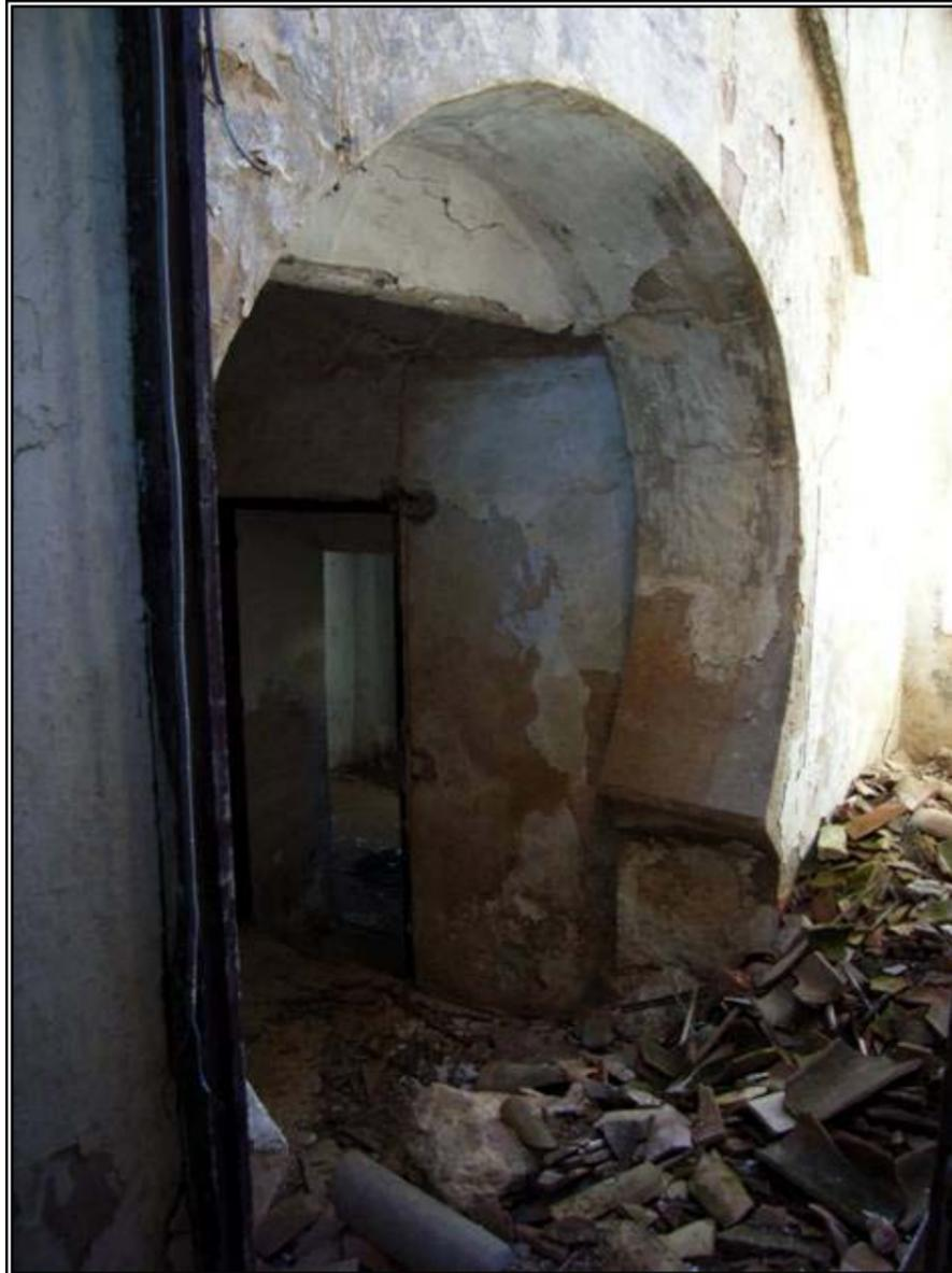
Arco de herradura utilizado para dividir las diferentes
