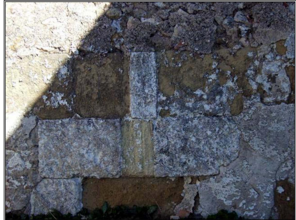
Detalle de la sillería, disposición a sogá y tizón.
