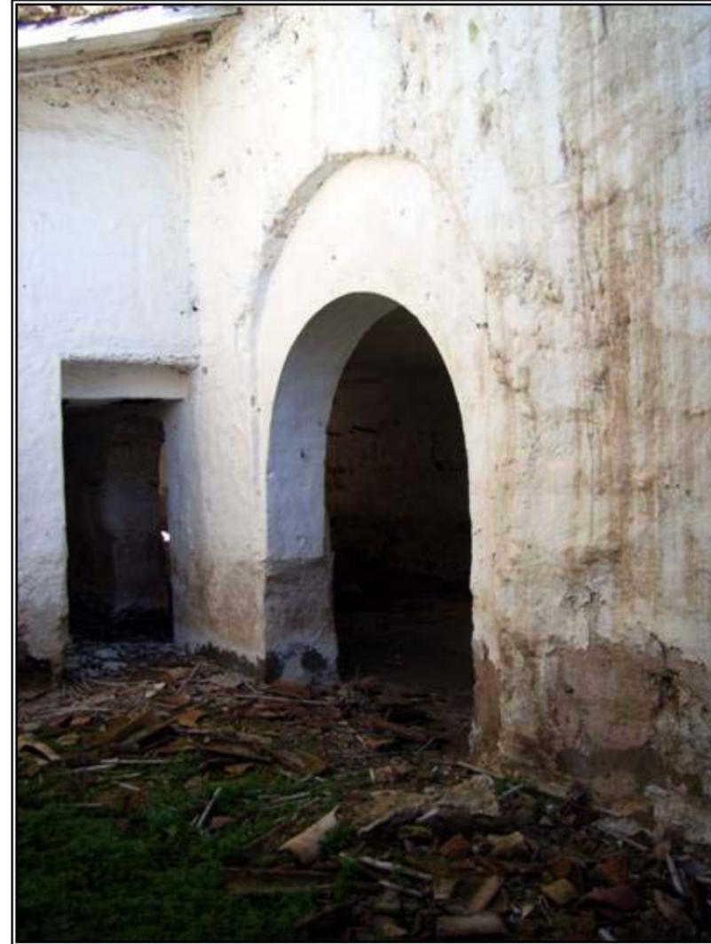
Primitivo arco de herradura con corrección posterior por reutilización.
