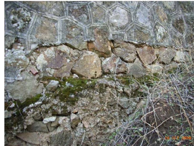
Canal del tramo 1º, restaurado en los últimos años con cemento para restituir la antigua tubería por una de uralita, sobre la arquería . Detalles.
