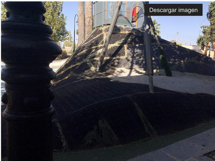
Concretamente, se van a reparar los montículos de caucho sustituyendo el césped artificial por una capa a base de poliurea, un material robusto y novedoso que se define como un polímero bicomponente de gran durabilidad que, en el caso de los montículos del parque de la Negrita, se proyectará en dos capas y tendrá color verde.
