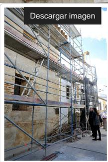
La restauración ha tenido lugar mediante la renovación o refuerzo de las estructuras dañadas de estos elementos de cubierta que, en el caso del camarín de la Virgen, se ha llevado a cabo mediante la ejecución de una losa ligera de hormigón armado, utilizando como encofrado la bóveda tabicada existente. Con respecto a la cubierta de la capilla mayor, se ha procedido a la
