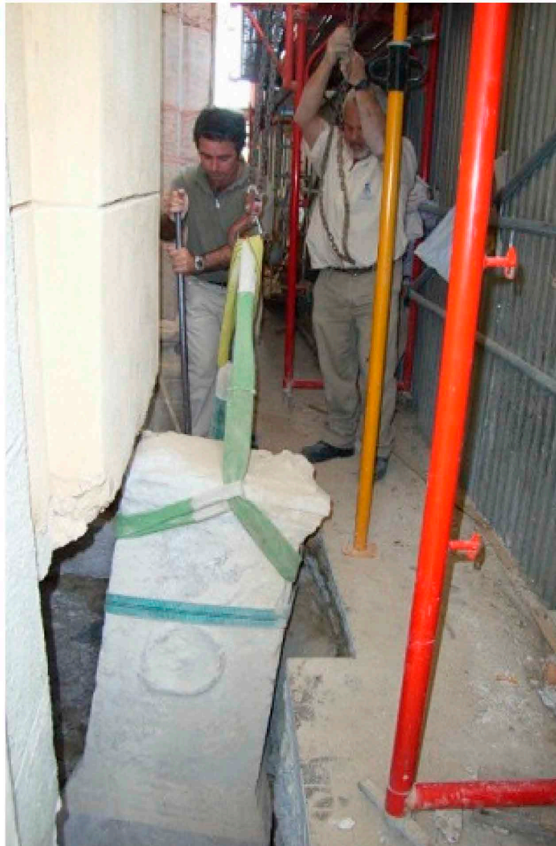
Localización y extracción de epígrafe en la fachada de San Juan de Dios
