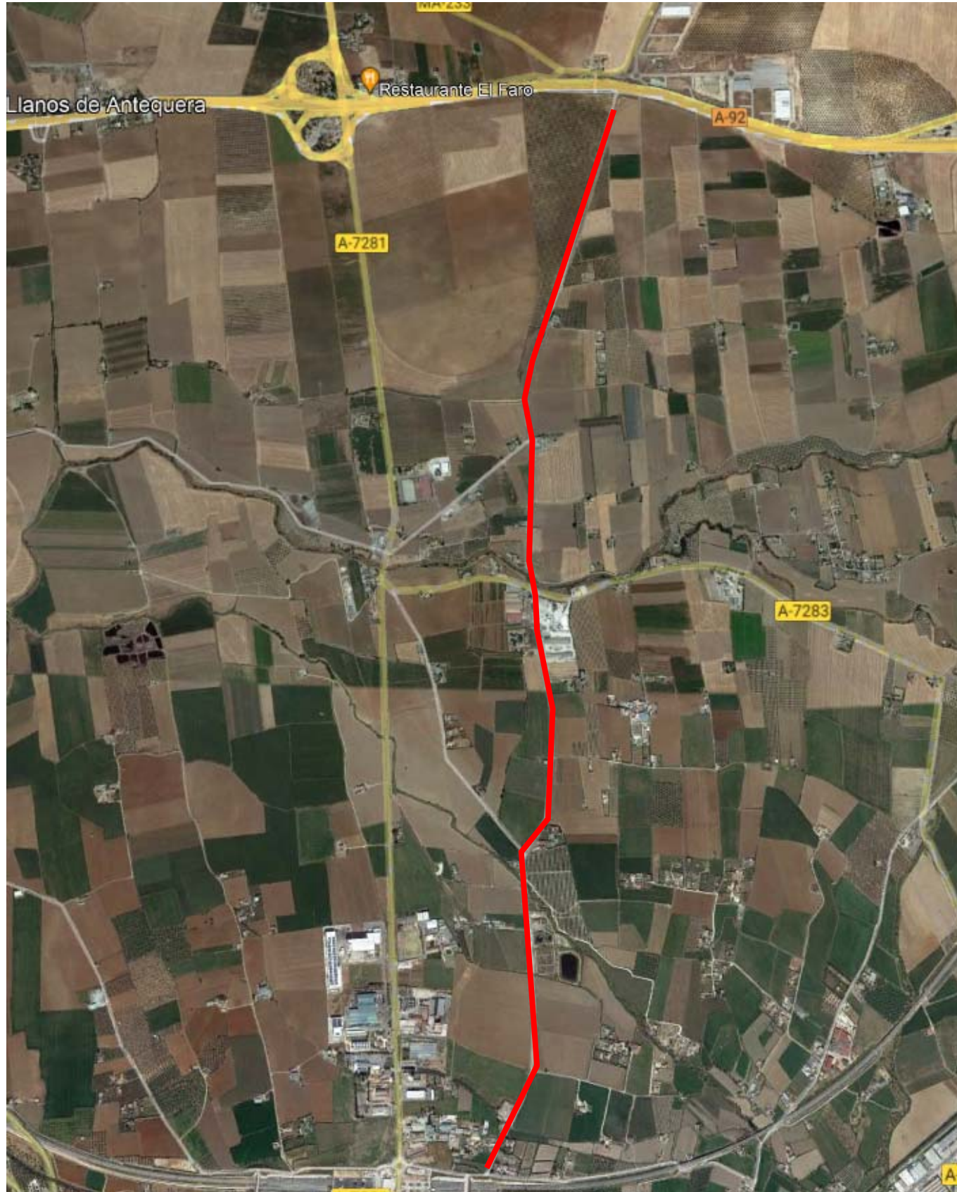
Tramo de carretera afectado
